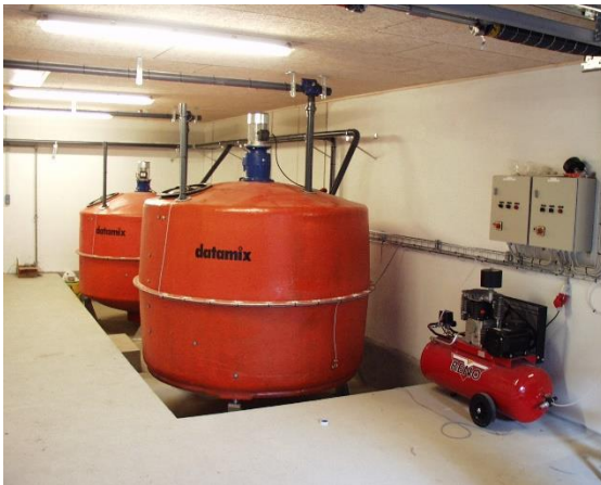
Nedsänkt tank underlättar daglig kontroll och skötsel
